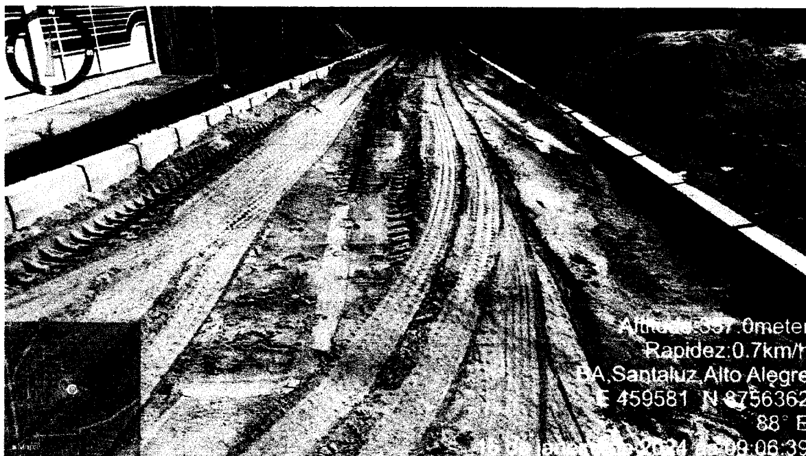
Execução de pavimentação caminho da saúde rua 09
