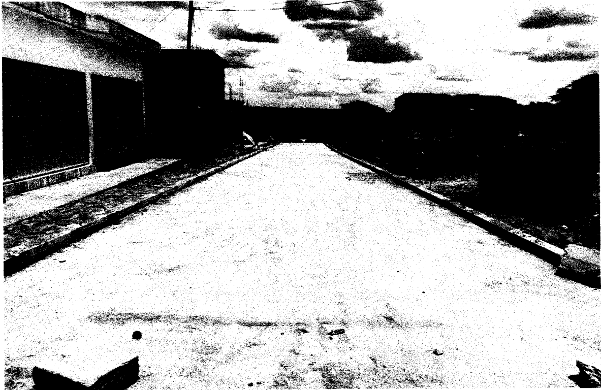
Execução de pavimentação cantinho da saudade rua 09
