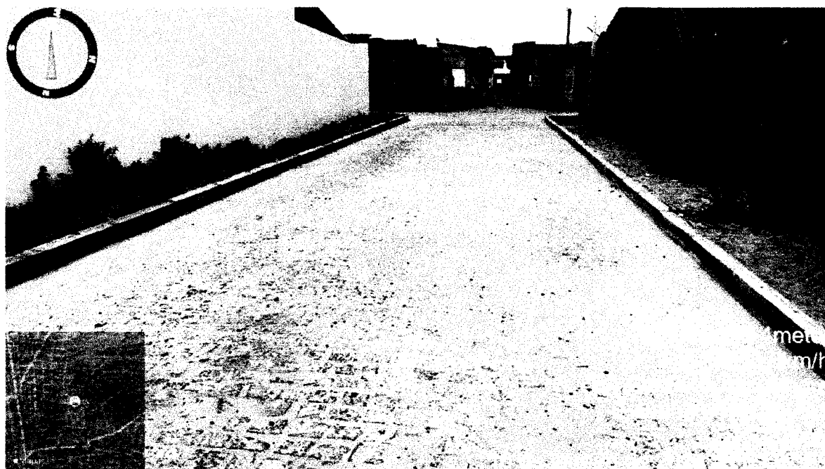
Execução de pavimentação caminho da saúde rua 08
